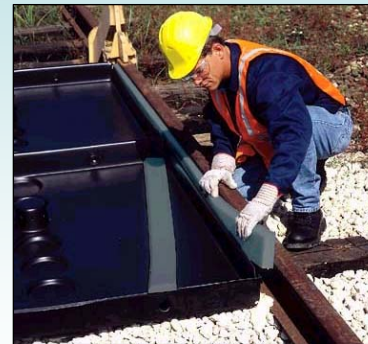
Se colocan los empaques de polietileno para completar el sello
