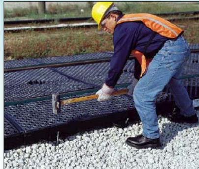
Una vez conectadas las charolas, se aseguran las laterales con anclas Rebar u otras
