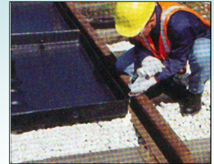
Se rellenan huecos con espuma de poliuretano
