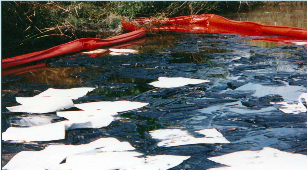
Limpieza de un derrame de hidrocarburos en una laguna con colchonetas PAD204
