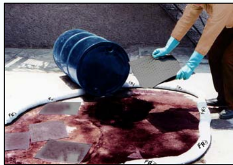
Limpieza de un derrame de hidrocarburos en una laguna con colchonetas PAD204
